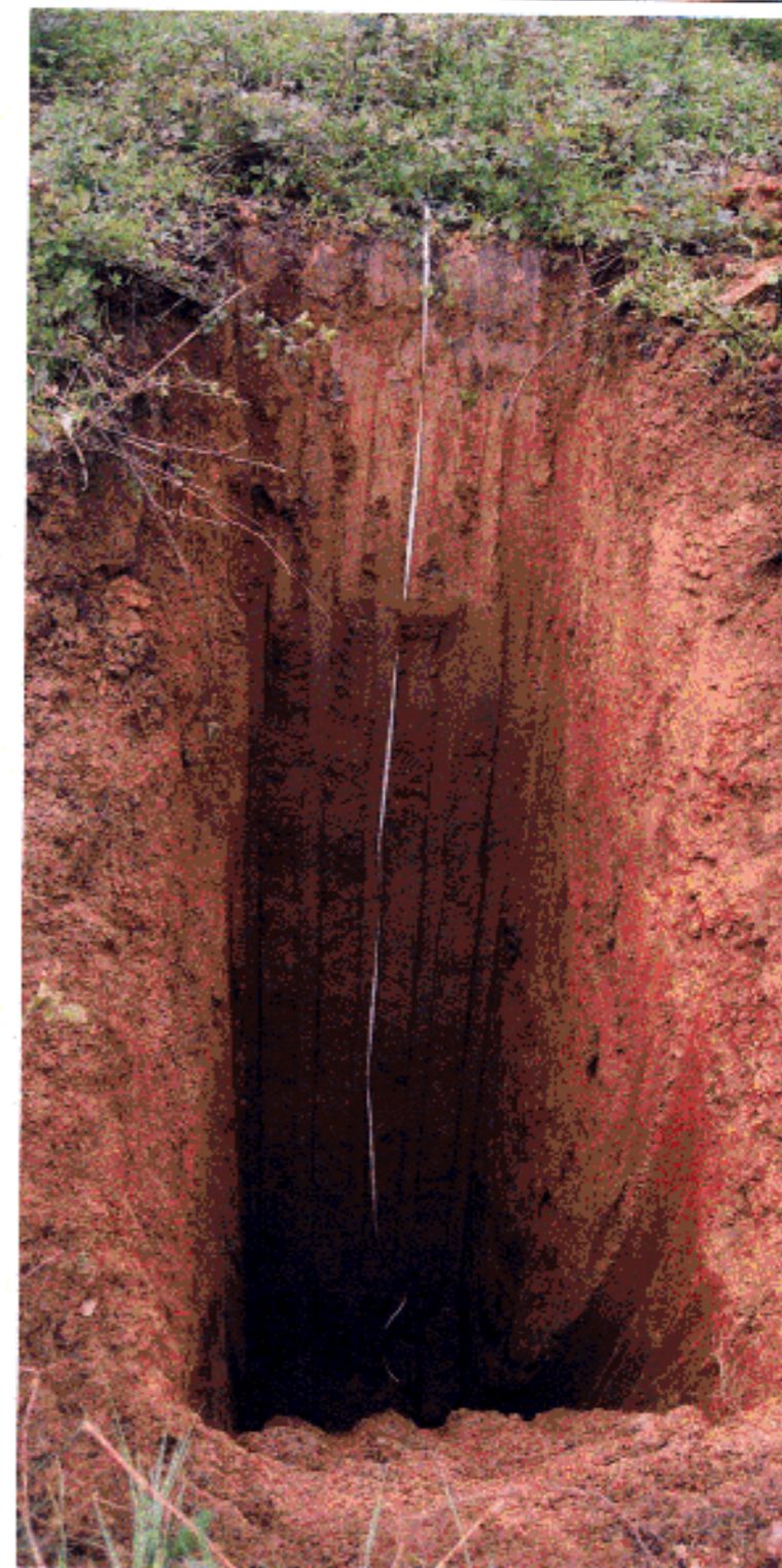
CALICATA C-21 PROFUNDIDAD FINAL = 4,80 MTS.
