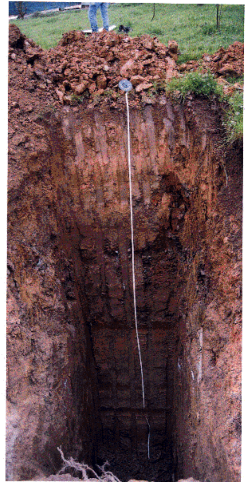
CALICATA C-3 PROFUNDIDAD FINAL = 4,20 MTS.
