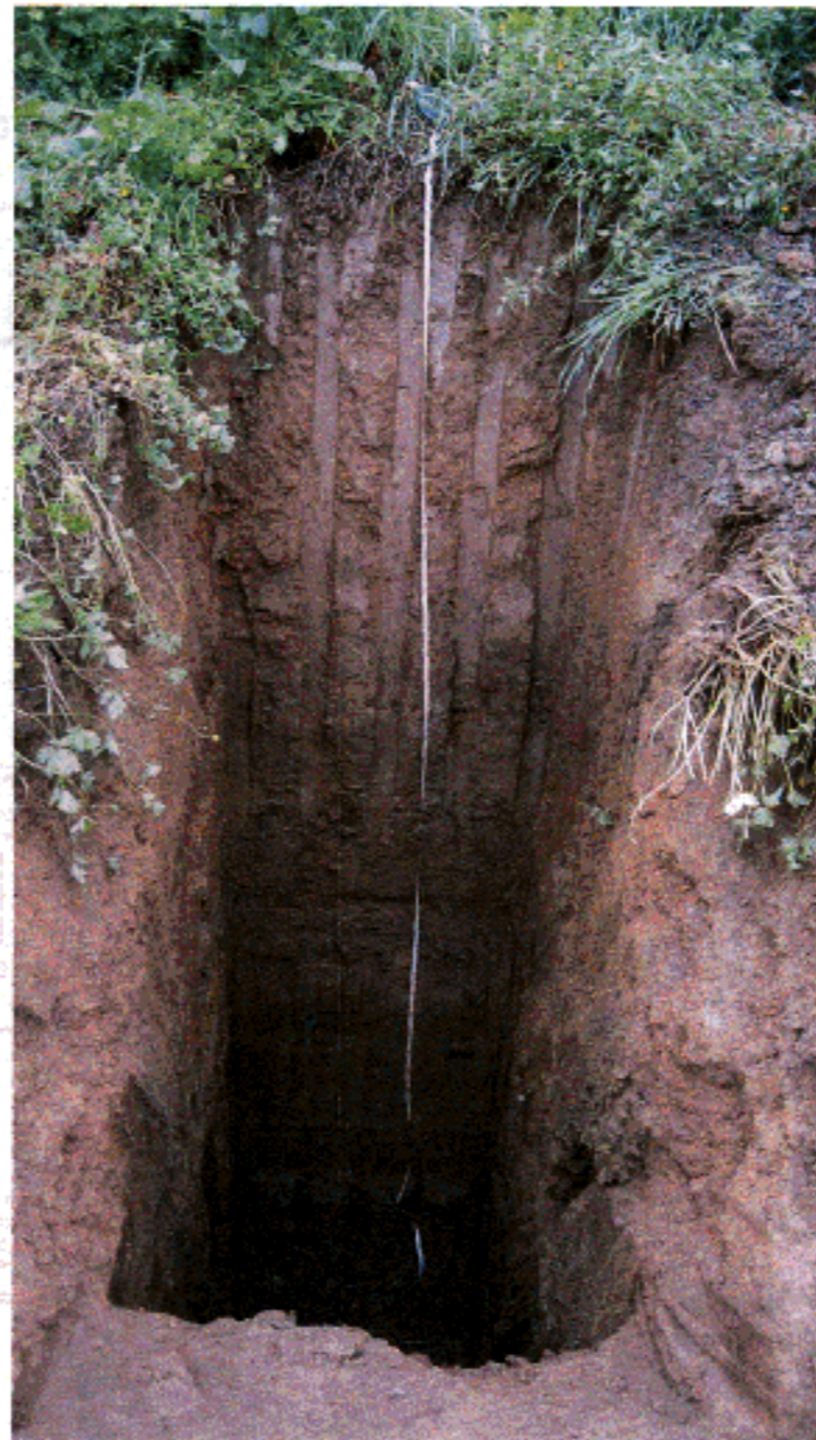
CALICATA C-14 PROFUNDIDAD FINAL = 4,20 MTS.
