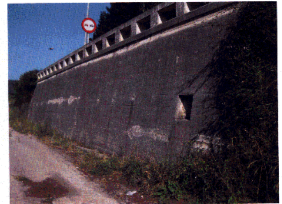
DETALLE DEL MURO DE HORMIGÓN BAJO LA GI-2632
