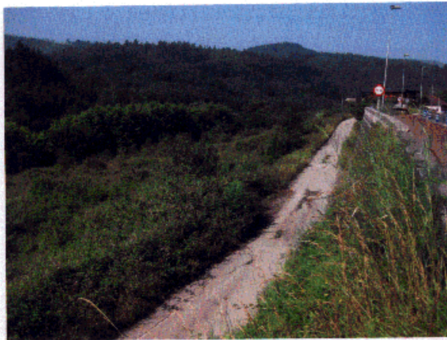
VISTA GENERAL DE LA ZONA DE DESMONTE BAJO LA GI-2632
