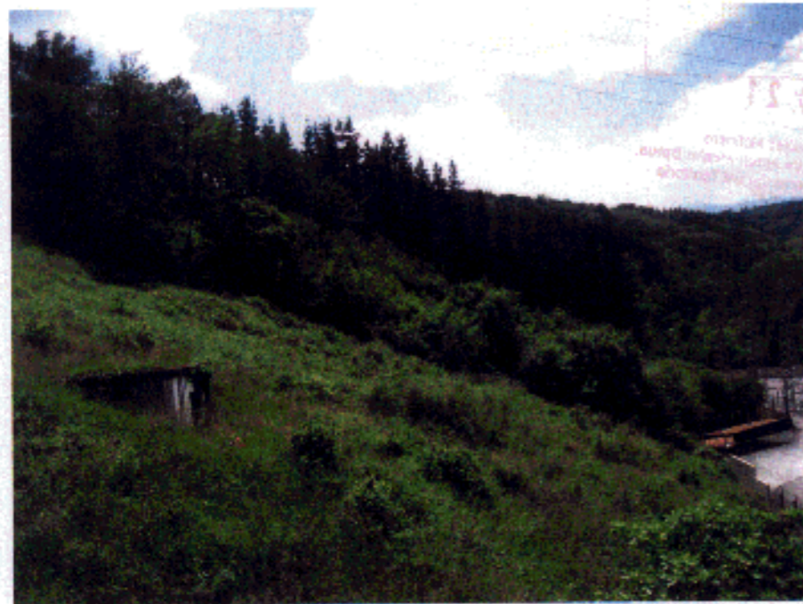
VISTA GENERAL DE LA LADERA SITUADA FRENTE A LA SUBESTACIÓN ELÉCTRICA
