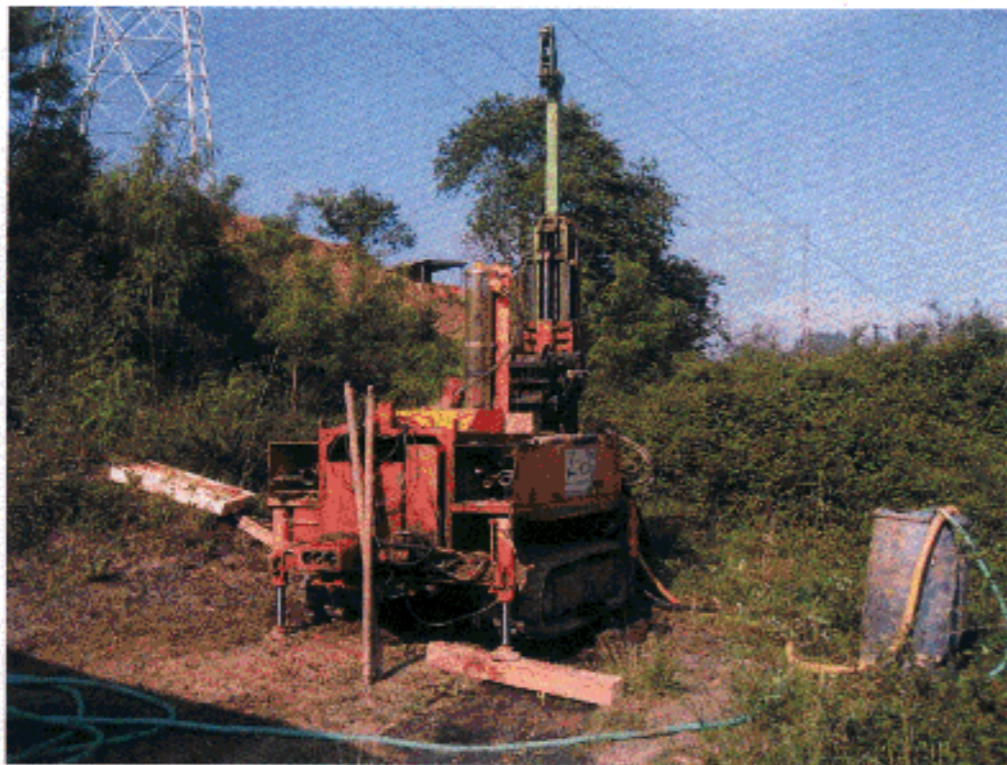
VISTA DEL EMPLAZAMIENTO DEL SONDEO S-2
