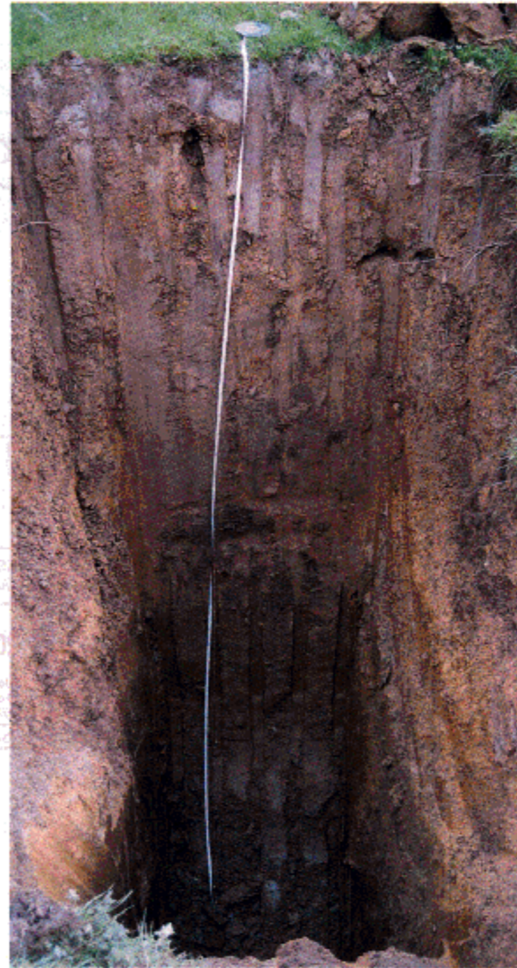
CALICATA C-5 PROFUNDIDAD FINAL = 3,80 MTS.
