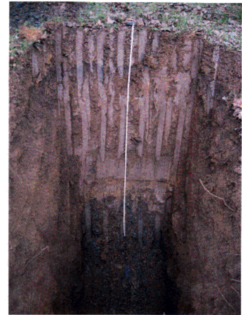
CALICATA C-6 PROFUNDIDAD FINAL = 2,80 MTS.
